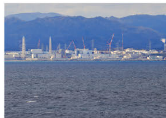
事故後の福島第一原子力発電所
